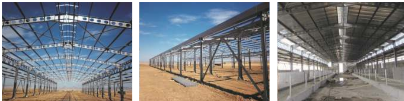
120 baş sağmal hayvan ahır yapısı çelik konstrüksiyon imalat ve montajı
