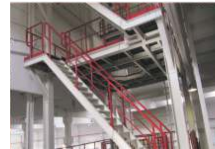
2400 mm ekstrüze hattı çelik konstrüksiyon imalat ve montajı
