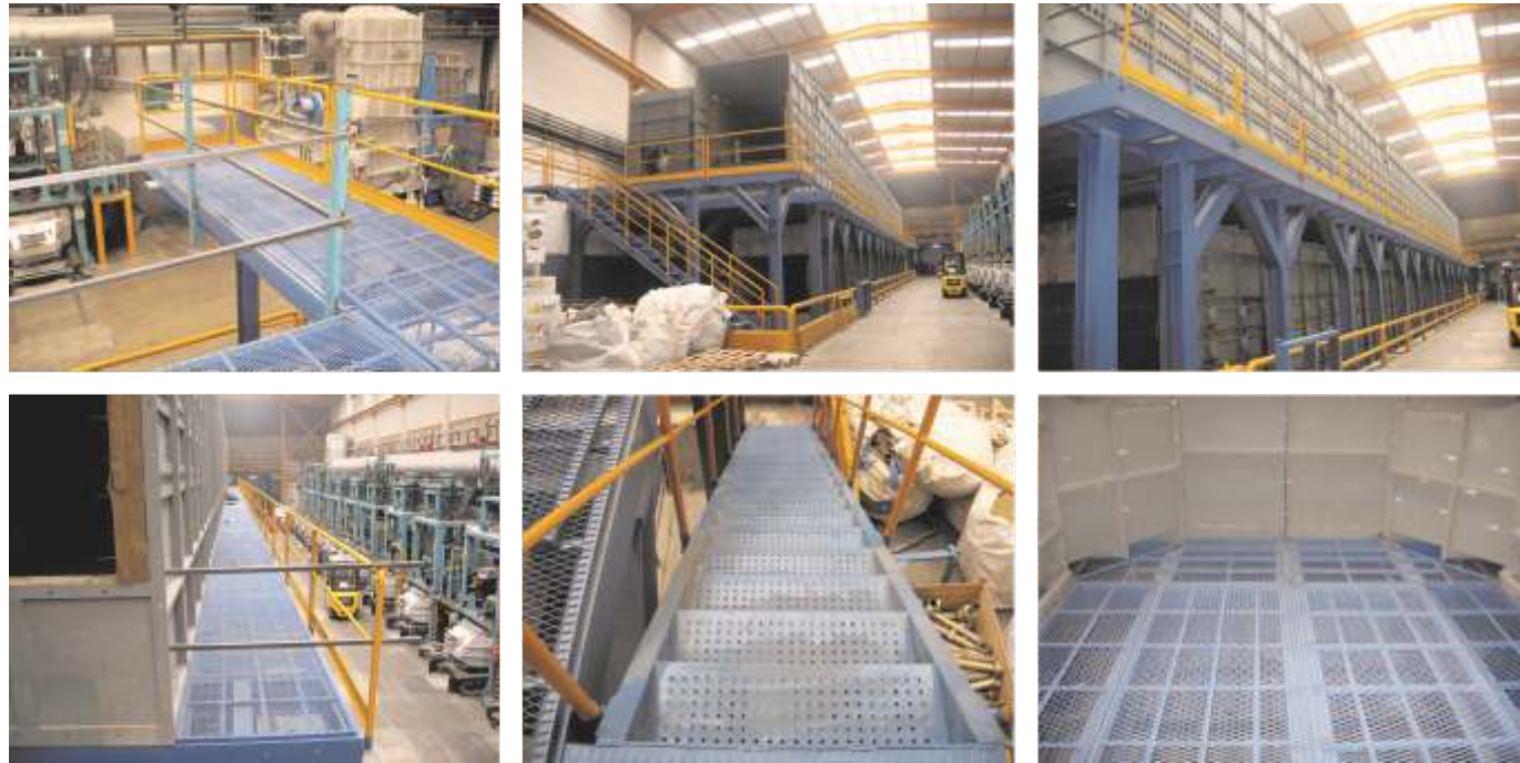
Ana bina 2. ısıtım hattı çelik konstrüksiyon imalat ve montajı
