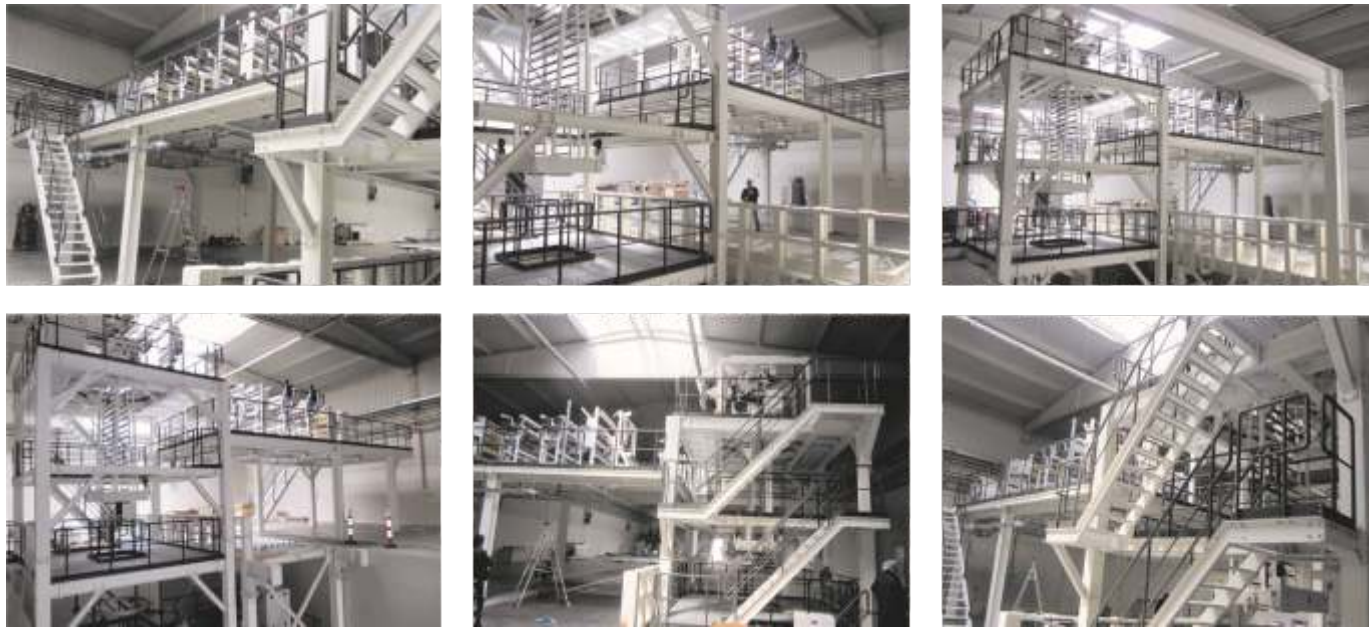
2600 mm ekstrüze hattı çelik konstrüksiyon imalat ve montajı
