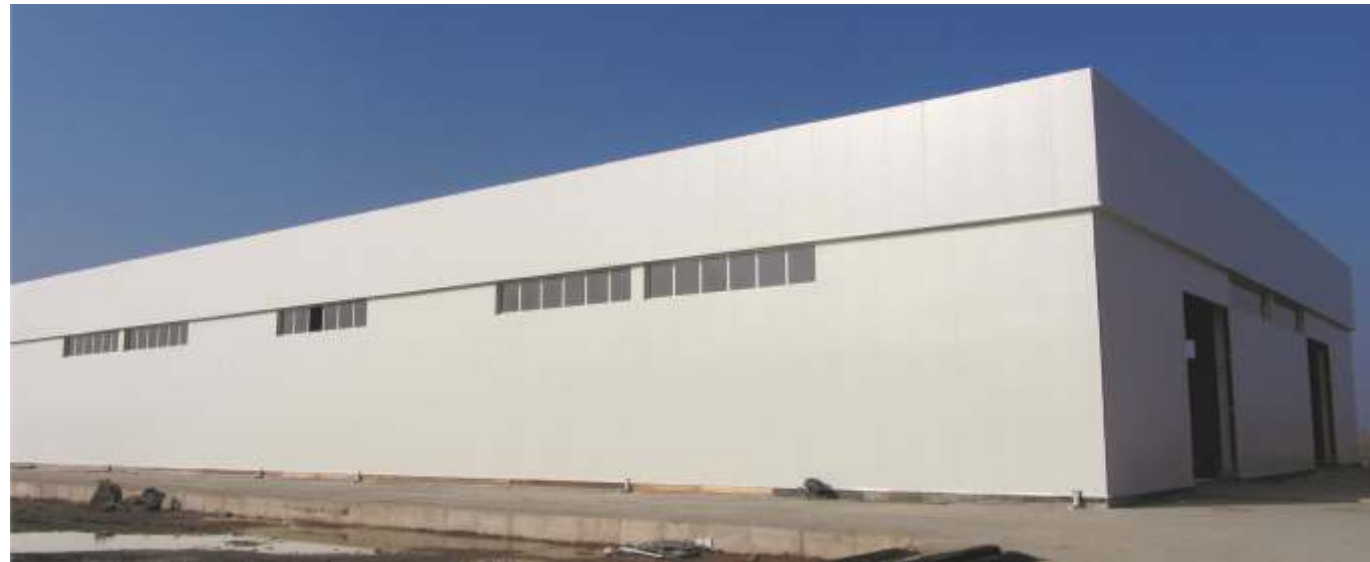
4000 m 2 Depo yapısı çelik konstrüksiyon imalat ve montajı
