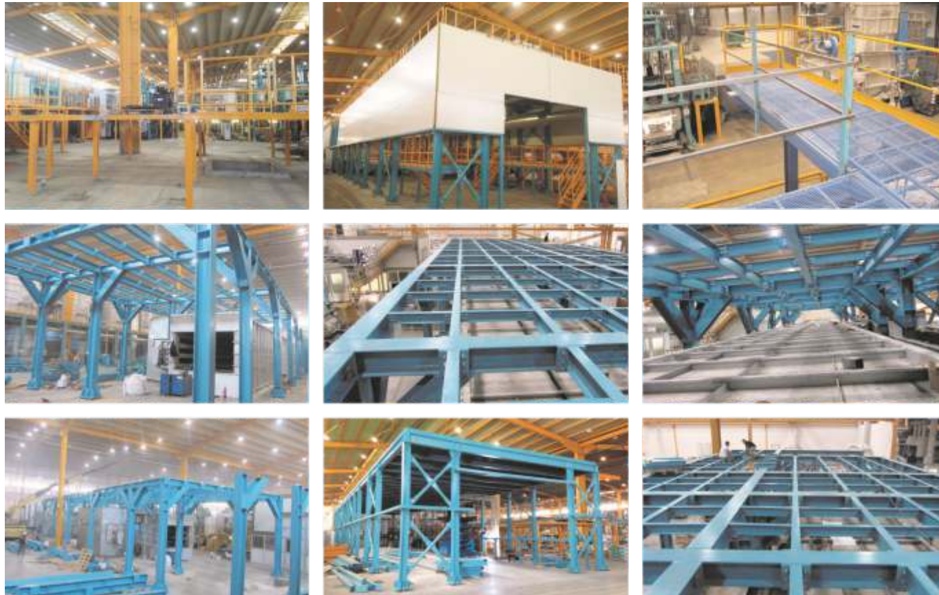
CMS JANT A.Ş. ESBAŞ Tesislerinde ısıtım hattı, x-ray ve alçak basınç hattı boyahane taşıyıcı sistemi konstrüksiyonları imalat ve montajı
