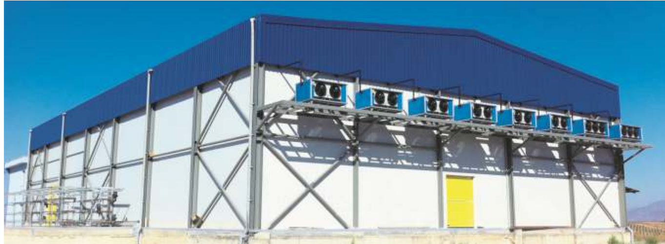
2200 m 2 soğuk hava deposu ve gıda işleme tesisi çelik konstrüksiyon imalat ve montajı
