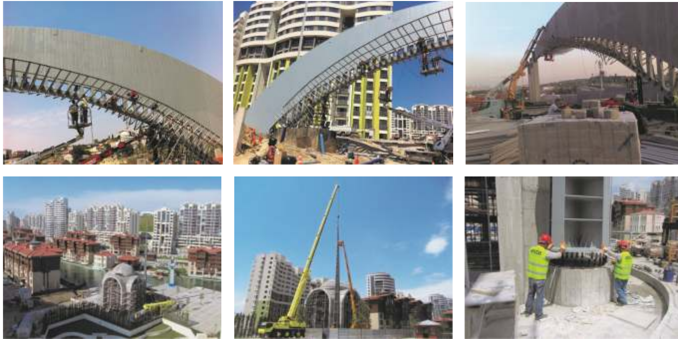
Sinpaş bosphorus projesi kapsamında ana giriş kapısı ve minare çelik konstrüksiyon imalat ve montajı
