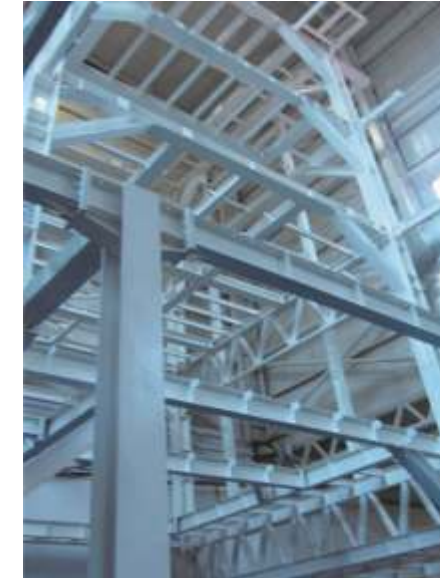
2600 mm ekstrüze hattı çelik konstrüksiyon imalat ve montajı
