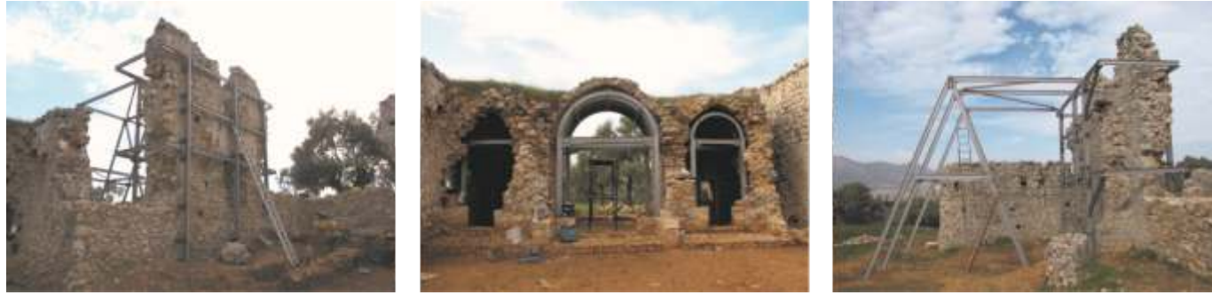
Yelli Medresesi mevcut duvarların ve eyvanların korunması için oluşturulan çelik konstrüksiyon kafesler.
