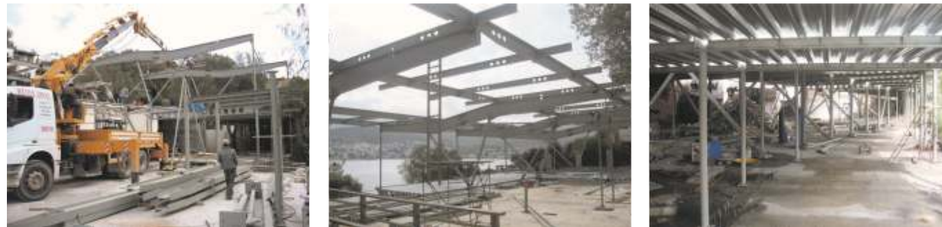
Minaresini Ahmet Alataş'ın yaptığı otelin restoran ve dinlenme alanlarının çelik konstrüksiyonlarının imalat ve montajı.
