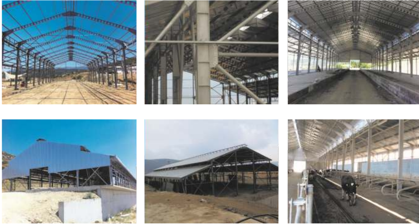
360 baş sağmal hayvan ahır yapısı betonarme ve çelik konstrüksiyon imalat ve montajı
